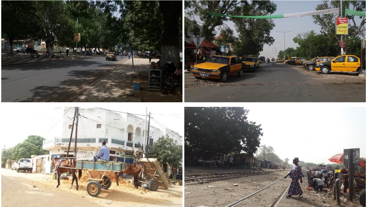
Figure 14 - État de la voirie, aménagements piétons et coupure urbaine de la voie ferrée dans la ville de Thiès
