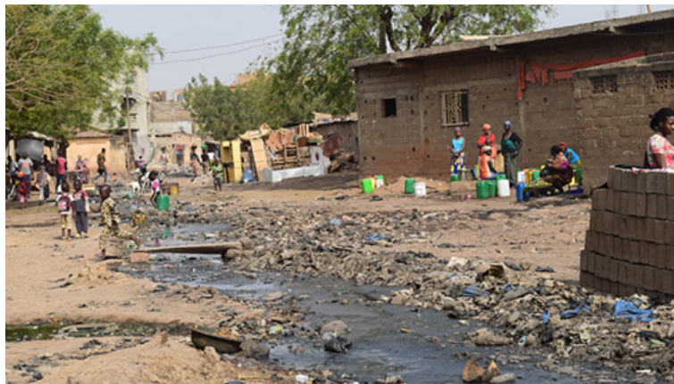
Figure 10 | Infrastructure du réseau tertiaire dans le quartier Sans-Fil 28
