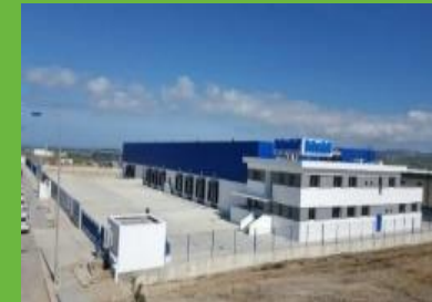
Plateforme logistique à TFZ
