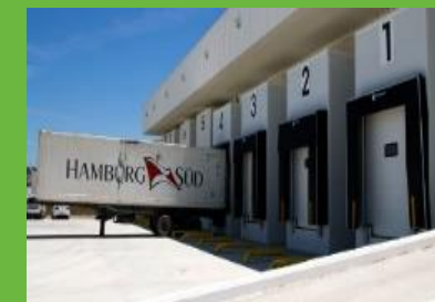
Entrepôt frigorifique Med Hub Tanger
