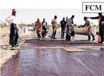
L'enduit à coulis se prête à la construction par des méthodes de travail à fort coefficient de main-d'œuvre.
