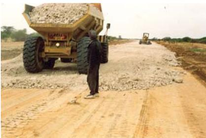
*Basée sur un cycle typique de rechargement de 3 à 4 ans et une épaisseur de gravier de rechargement de 100 mm sur une chaussée large de 6.5 m, la consommation annuelle de gravier dans la région est de l'ordre de 150 millions de mètres cubes. Est-ce que ce procès est durable au moyen ou long terme ? Non!*
