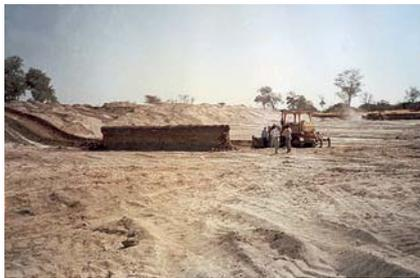
Une épaisseur importante du sol végétal parfois empêche l'emploi de méthodes à fort coefficient de main-d'œuvre pour l'obtention des matériaux graveleux (L'exemple ci-dessus provient de la construction d'une RRFVC où l'épaisseur du sol végétale excédait 2m.)
