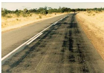
Ressuaage résultant de l'enfoncement des granulats du revêtement dans la couche de base.
