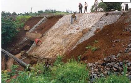
La capacité inadéquate d'un ponceau, surtout en combinaison avec des remblais élevés peut résulter en dommage sévère et des travaux curatifs coûteux.
