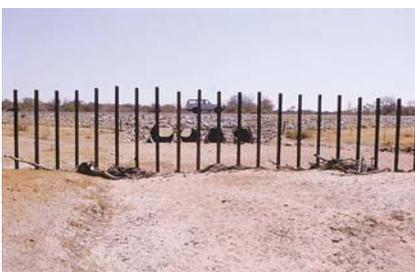
La protection à l'amont contre le blocage par des arbres peut être construite avec du succès en vieilles traverses en fer, qui sont bien ancrées dans le lit de la rivière.
