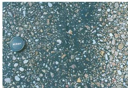
Enduit Otta avec un enduit à sable.
