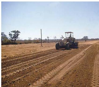
En enlevant le patron laissé par les rouleaux à grille dans la surface de la couche de base, il est important d'assurer que toutes les stries laissées par le traînage sont remplies immédiatement et avant la mise en œuvre des rouleaux lisses.
