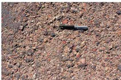
Un exemple d'un enduit Otta double (avec de granite décomposé) après 10 ans en service dans un environnement dur et semi-aride sans presque aucun entretien.
