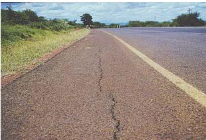
Fissuration longitudinale et déformation typiques de la chaussée provoquées par les changements importants de volume dans le sol expansif dans la sous-couche.
