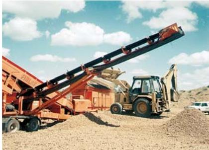
Les caractéristiques opérationnelles de l'enduit Otta permettent l'utilisation de gravier naturel brut qui peut être criblé - s'il se trouve nécessaire - afin d'enlever les fines et le matériau trop grand.
