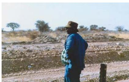
Le contrôle visuel continu par du personnel expérimenté pendant l'opération entière pendant le traitement de la couche de base des RRFVC est indispensable. Le compactage inadéquat de graviers naturels est souvent imputable au malaxage pauvre, une teneur en eau insuffisante ou au répandage et compactage finaux de l'assise.
