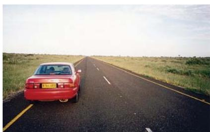
Terrain plat avec peu de contrainte sur les normes géométriques.
