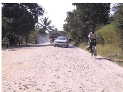
A cause de la perte des fines, les routes en gravier souvent deviennent très rugueuses, qui rendent les conditions de conduite dangereuses et, en plus, du manque sévère de confort du conducteur, aboutissent à des coûts très élevés de l'exploitation des véhicules.
