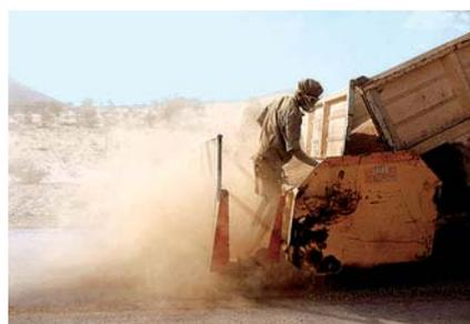
Des teneurs élevées en poussière et fines dans l'agrégat sont plus cruciales pour la bonne performance d'un enduit superficiel que pour celle d'un enduit Otta.
