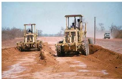
Les niveleuses sont versatiles pour le traitement des matériaux sur la chaussée.
