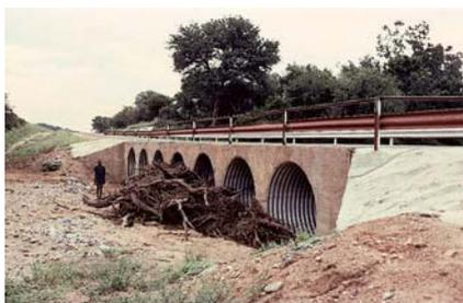
Des ponceaux à bancs de tuyaux sont susceptibles d'être bloqués par des arbres, même quand on utilise des tuyaux à grand diamètre.
