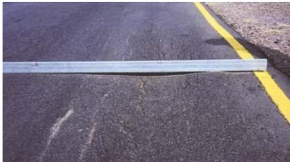
Un exemple de l'orniérage dû à la déformation permanente de la couche de base occasionnée par la densification du matériau.
