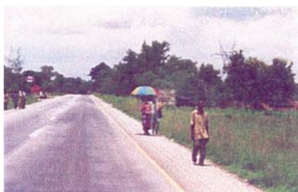
*Si la construction d'un sentier séparé n'est pas possible, de larges accotements scellés constituent une surface acceptable pour la marche à pied ou pour le cyclisme.*
