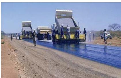
*L'exécution d'un enduit superficiel typique – le répandage d'une assise mince de bitume sur la surface de la route avant d'y placer de l'agrégat.*
