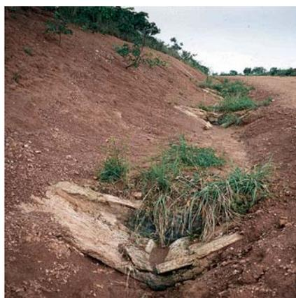
Des obstacles à l'affouillement en béton dans un drain latéral.
