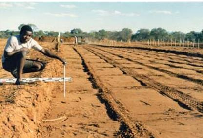
Tassement d'effondrement de plus de 150mm après compactage par un rouleau à chocs.
