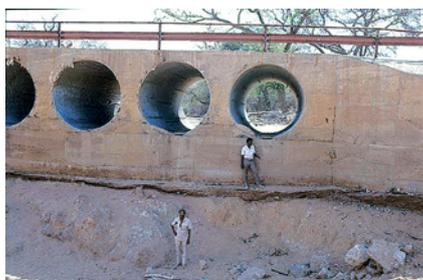
S'il existe le risque de l'érosion aux débouches, des radiers convenables et d'autres mesures de protection sont requis.
