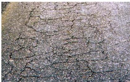
La fissuration du revêtement principalement à cause de l'oxydation et du durcissement conséquent du liant bitumineux.
