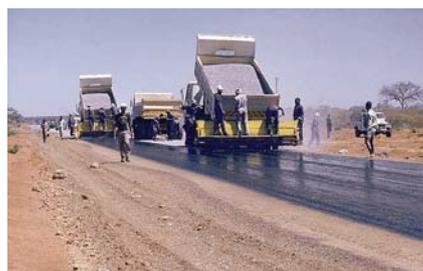
Le répandage de l'agrégat pour des enduits superficiels à l'aide des gravillonneurs mécaniques.
