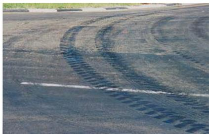
Le freinage sévère et des virages aigus nécessitent un choix approprié de revêtements de forte stabilité. Le béton bitumineux et, éventuellement les enduits du Cap ou des enduits doubles Otta seraient préférables à des enduits à sable, à coulis, aux gravillons ou à des enduits Otta simples.
