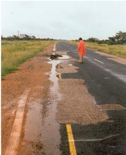
L'infiltration de l'eau dans l'accotement, aboutissant à des défaillances aux rives.
