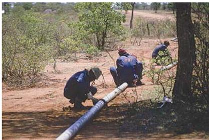
La fourniture de l'eau de construction peut nécessiter la construction de canalisations temporaires.
