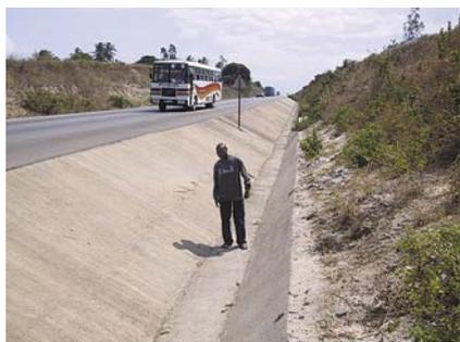
Des fosses profondes de drainage en forme de V ne laisse aucune possibilité de rétablissement si un véhicule quitte la route.
