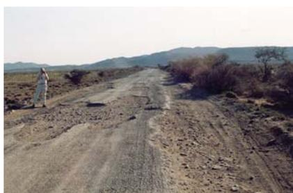
Un exemple d'une route sévèrement dégradée qui a reçu peu – ou point – d'entretien depuis sa construction. Le résultat est des coûts très élevés d'exploitation de véhicules et la perte de la plupart du placement financier original.
