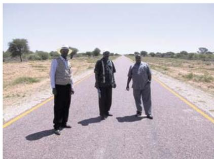
Un exemple d'un enduit Otta simple avec un enduit de scellement à sable dont la performance est encore très satisfaisante après plus de 13 années de service dans un environnement sévère, sans aucun entretien du revêtement.
