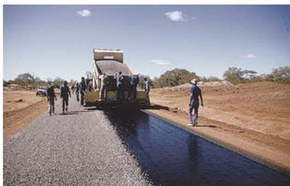
Le contrôle visuel de la répanduse de bitume et l'examen continu du travail sur chantier constituent des parties importantes des procédés de contrôle de qualité et peuvent réduire les défauts en enduits minces qui pourraient aboutir à la défaillance prématurée du revêtement.
