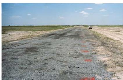
Un exemple de dommage sévère au revêtement d'une piste d'aviation à cause des effets des sels en moins de deux ans après sa construction.
