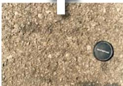
Perte de la deuxième assise d'un enduit à cause du durcissement et friabilité du bitume.
