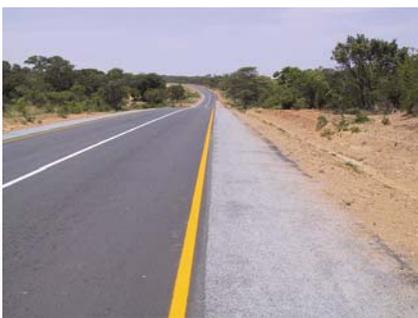
Le sablage des enduits de scellement des accotements avec un enduit bitumineux à sable est souvent une méthode appropriée de:
