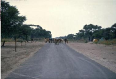
Dans le nord, on a amélioré une piste de sable de 45 km en recourant au seul matériau disponible, le sable calcifié, pour la transformer en une route en grave entre 1980 et 1982. La chaussée s'est toutefois détériorée rapidement, même si le trafic n'y était que de 20 véhicules
