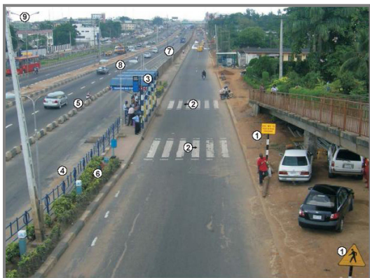
Voie d'autobus BHNS : dispositif type de convergence/bifurcation
